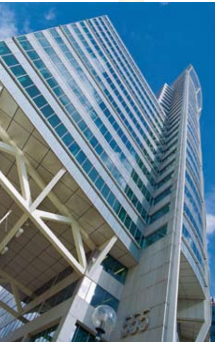
Ein Objekt der KanAm grundinvest Blaak 555, Rotterdam
