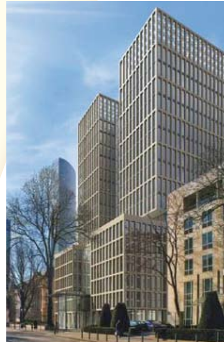
Ein Objekt des CS Euroreal Bürogebäude An der Trift 65, Dreieich
